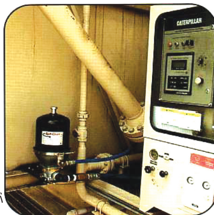
ロータリーコンプレッサーのオイル浄化用に設置されている、モデル1000-OCB
